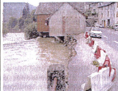
Érosion de berges à Lods (25) - 2006 (Source DLA)
