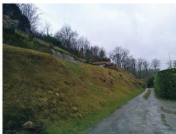
Sur talus localisé en remblais (de moins de 10m de haut)
