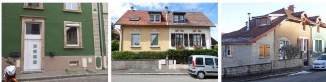
Illustration | Altérations et transformations sur patrimoine bâti : appauvrissement des baies, changement de matériaux, extensions, modification de la silhouette ou du gabarit...
