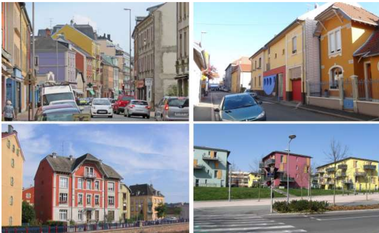
illus. : Deux exemples de façades traditionnelles mises en valeur par la couleur, et deux autres exemples avec une architecture plus contemporaine.
